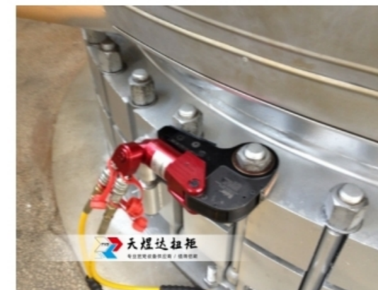
TYD-SHW3在变电站使用
